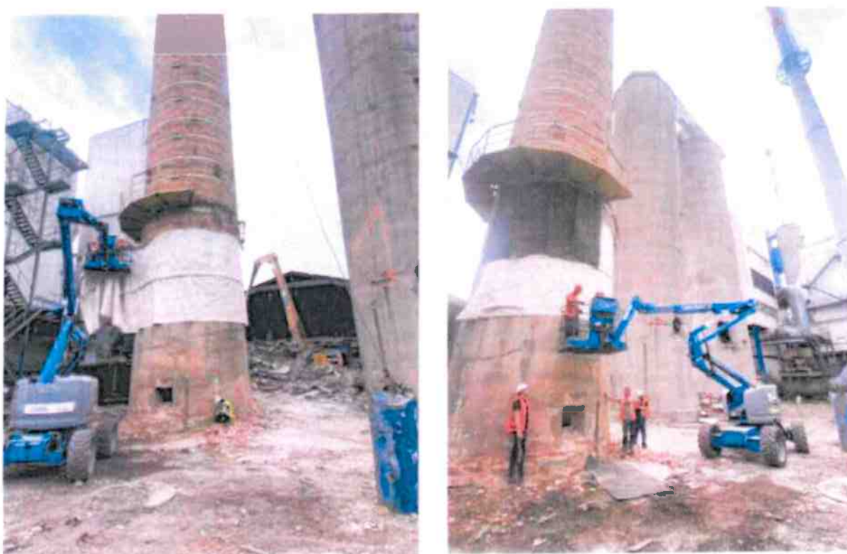
Fot. 7-8. Zabezpieczenia bezpośrednie z gum i geowłókniny na kominie.
