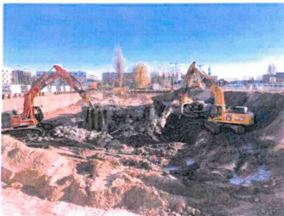
Fot. 9. Przykład wyburzania fundamentów metodą mechaniczną.
